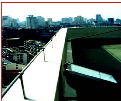
接闪带支架安装示意图
