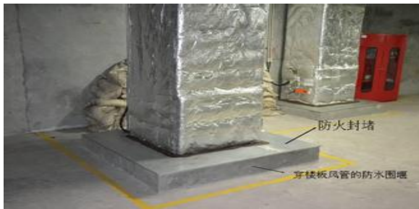
风管穿楼板安装
