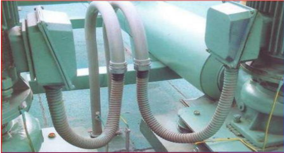
室外电动机接线实例图
