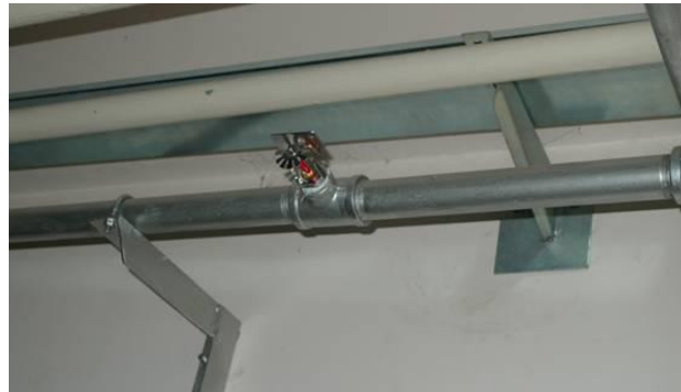
边墙型喷头安装实例图
