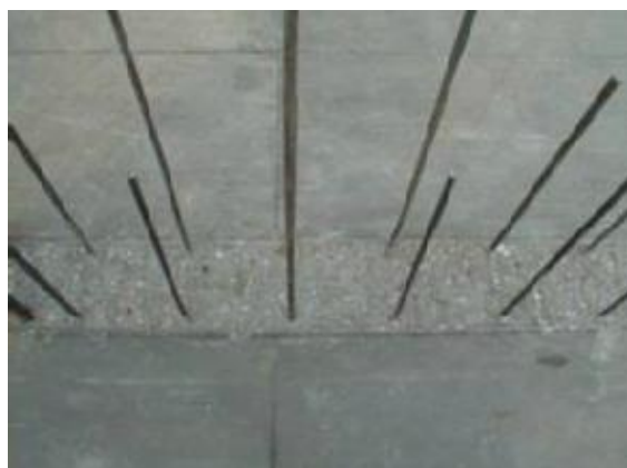
剪力墙施工缝凿毛图
