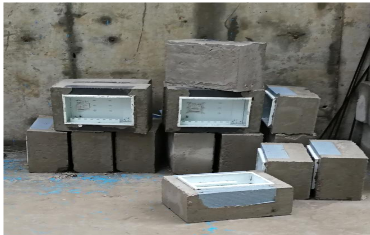
配电箱预制成成品块实例图
