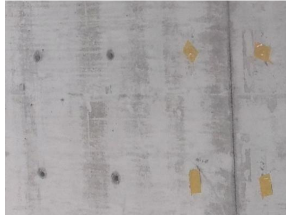
外墙对拉螺栓眼封堵养护实例图
