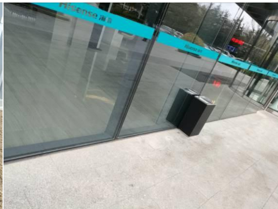
幕墙底部为石材饰面部位实例图
