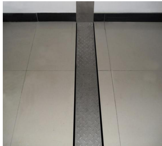
金属盖板变形缝做法实例图
