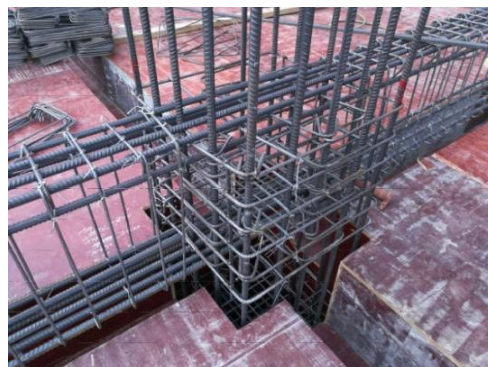
梁柱核心区钢筋绑扎实例图
