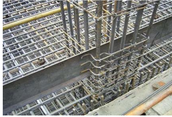
止水钢板穿墙柱做法实例图一
