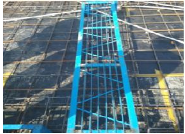
楼板钢筋马道实例图
