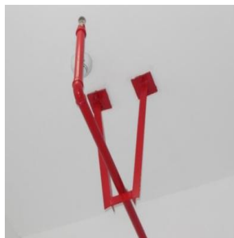
末端喷头防晃支架实例图
