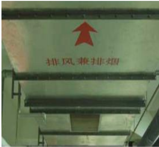
字体在风管底部标识实例图
