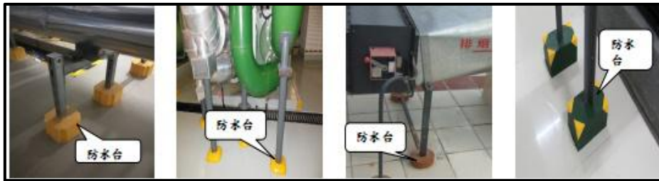
落地支架根部防水措施
