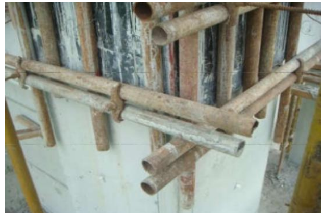
柱水平施工缝模板下延实例图
