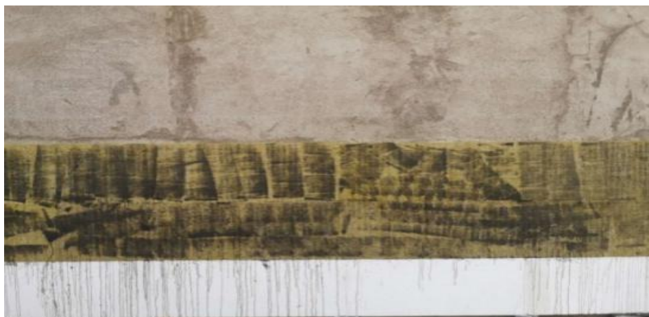
外墙岩棉保温最下排做法实例图
