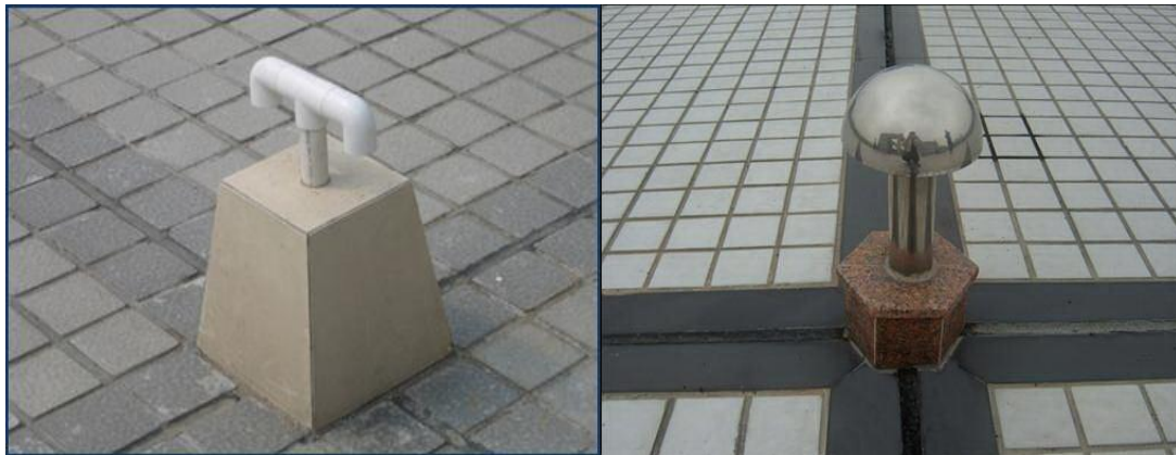
屋面不锈钢排气孔实例图
