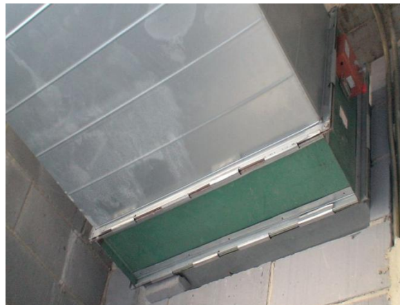
风管共板法兰连接示意图
