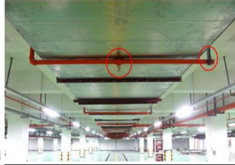
风管底部喷头实例图
