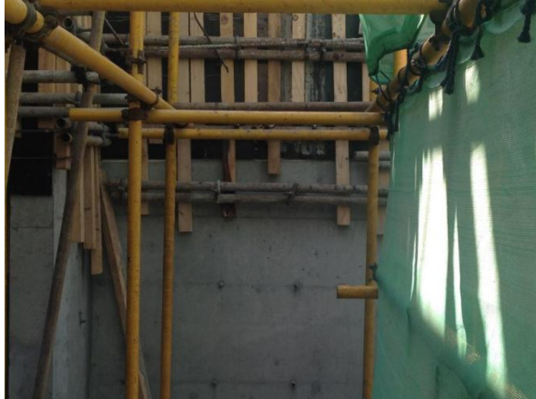
墙水平施工缝模板下延实例图
