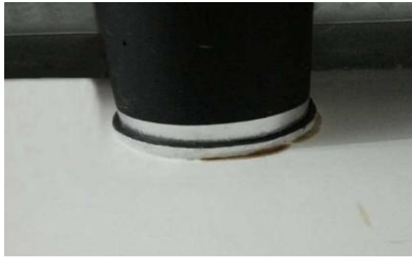
绝热管道穿楼板实例图
