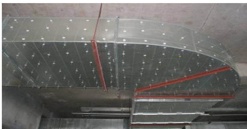
风管绝热实例图
