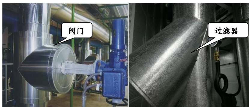
阀门、过滤器保护壳施工
