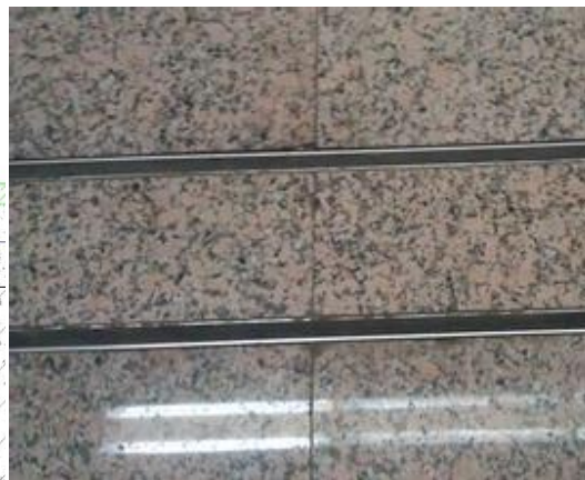
石材地面变形缝做法实例图
