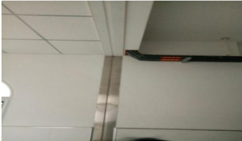
吊顶部位变形缝做法实例图
