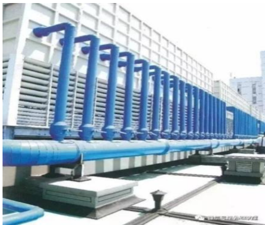
成排冷却塔布置实例图
