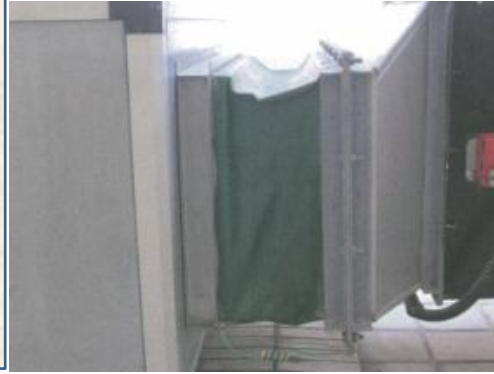
风机软连接实例图
