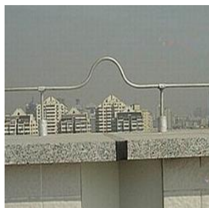
接闪带变形缝处做法实例图
