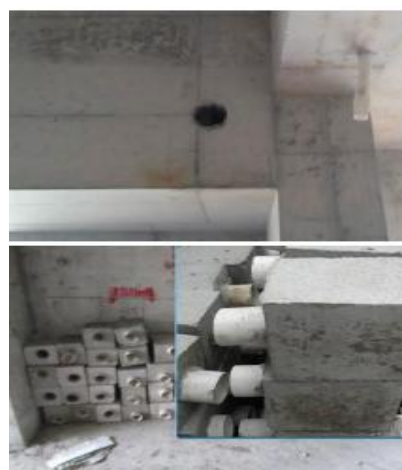
空调孔砼预制件实例图
