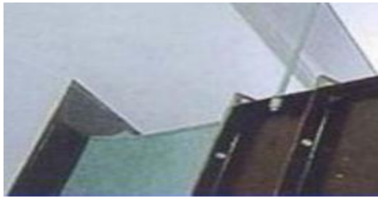
风管穿防火（防爆）墙实例图
