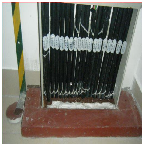
梯架穿楼板封堵实例图
