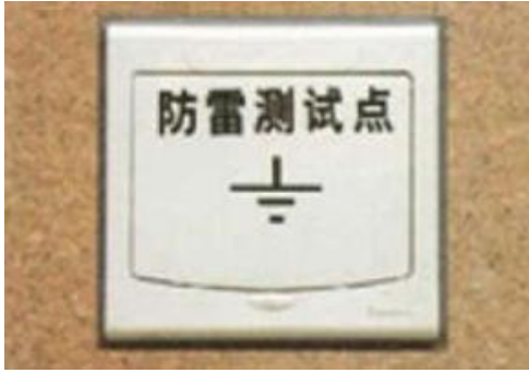
接地测试点实例图
