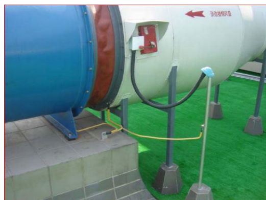
有振动设备接地实例图
