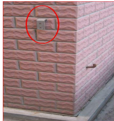
明设接地测试点实例图
