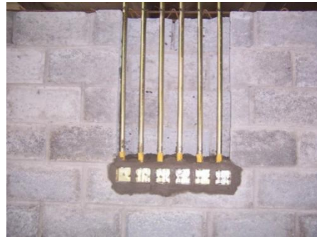
砌体墙线管、线盒安装实例图
