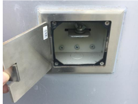
接地测试点实例图
