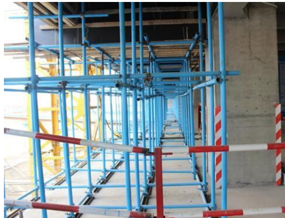
后浇带架体分色搭设实例图
