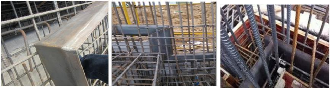
止水钢板转角实例图
