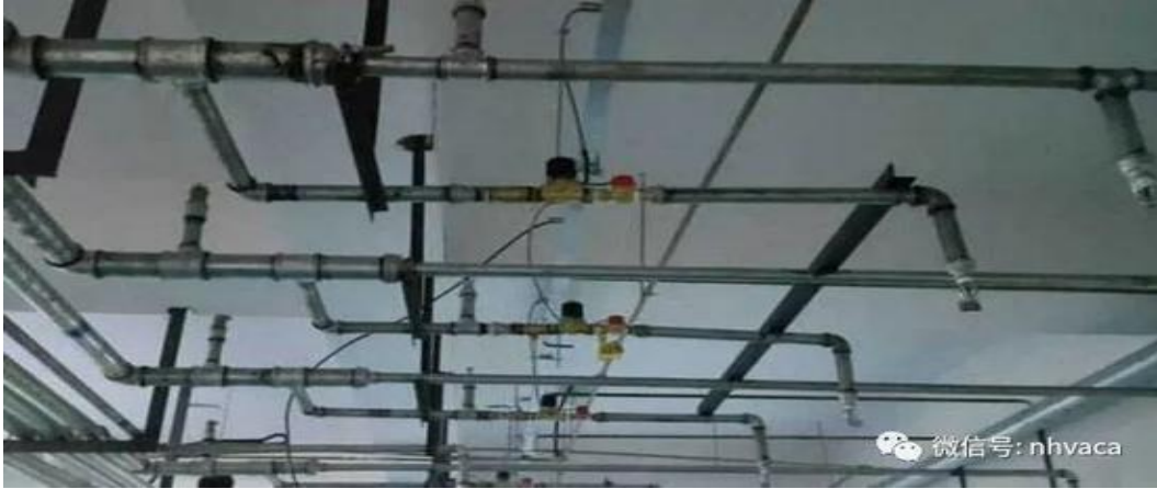
直立型喷头安装实例图
