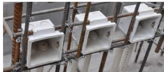
成排线盒绑扎固定实例图
