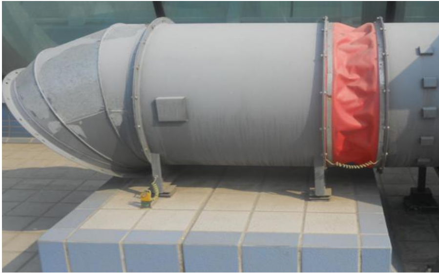
风机落地安装实例图
