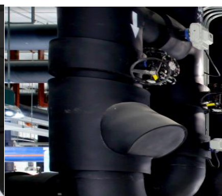
过滤器绝热实例图
