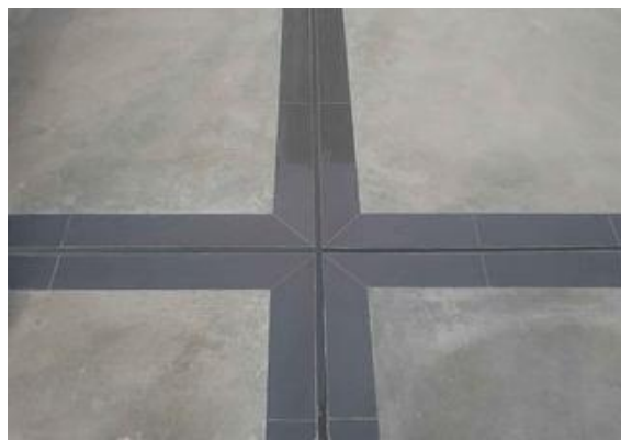
聚氨酯砂浆嵌缝实例图
