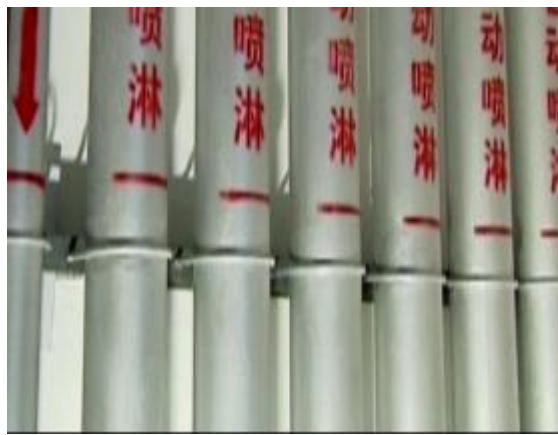
成排竖向管道标识做法实例图
