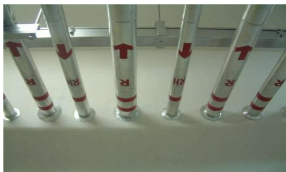
绝热管道穿墙体实例图
