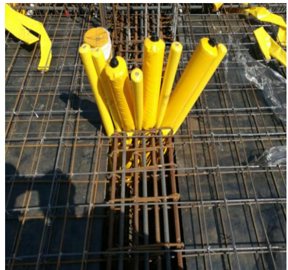
混凝土分隔气囊封堵实例图
