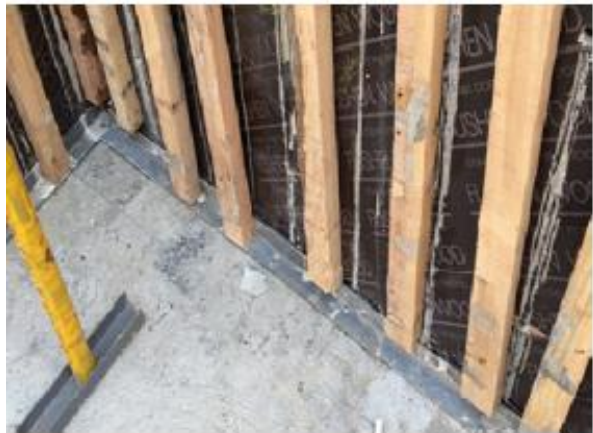
墙柱模板根部加设角钢实例图
