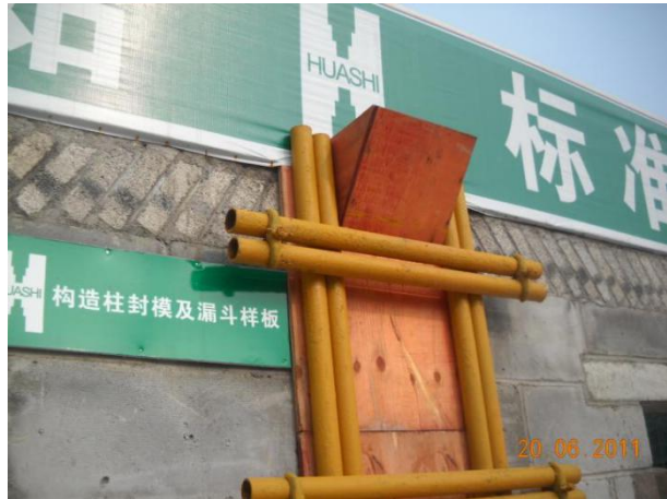
二次结构模板安装实例图
