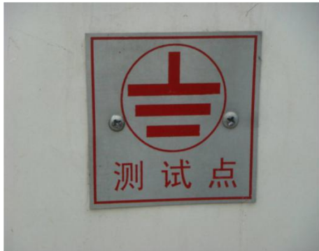
暗装接地测试点实例图
