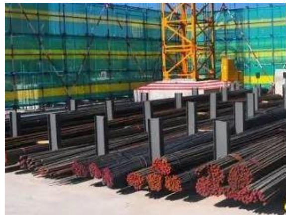
钢筋原材料堆放支架实例图
