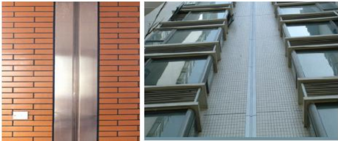
外墙变形缝连接做法实例图
