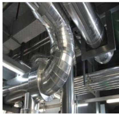
管道弯头保护壳做法实例图
