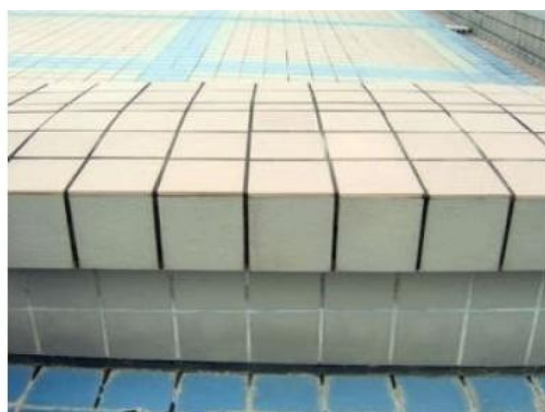
饰面砖面层变形缝盖板实例图
