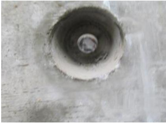
三段式对拉螺栓拆除后实例图
