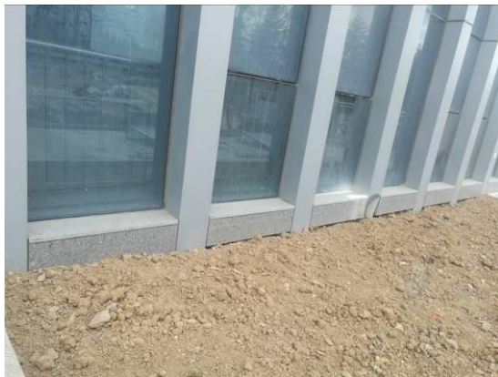
幕墙底部为回填土部位做法实例图
