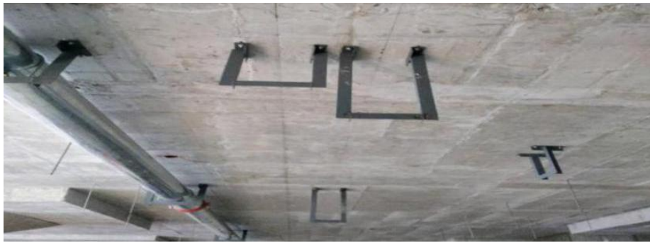
支吊架安装定位放线
