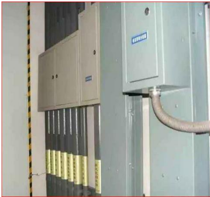
电气竖井接地干线实物图
