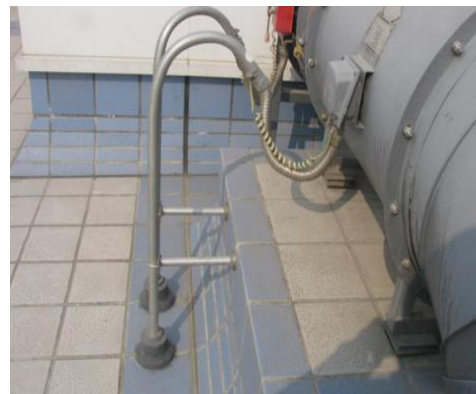
室外风机接线实例图
