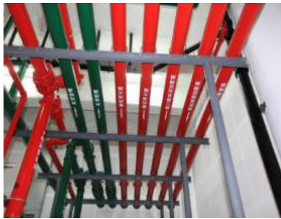
成排水平管道标识做法实例图
