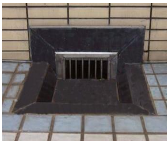
横式落水口实例图
