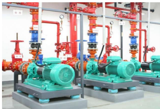
卧式水泵弹簧减振器安装实例图
