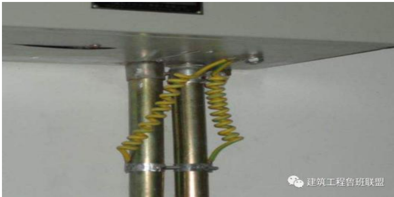
槽盒进出 SC 线管锁母连接实例图
