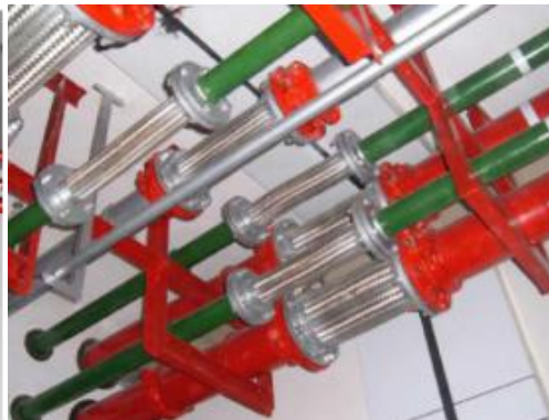
管道过变形缝做法实例图
