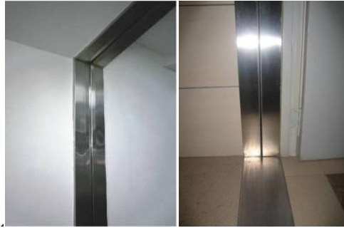
内墙、顶棚变形缝实例图
