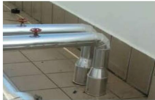
绝热管道穿屋面实例图
