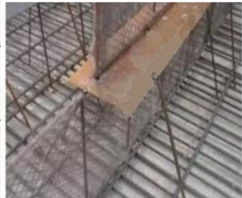
地下室底板后浇带止水钢板实例图
