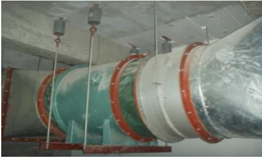
风机吊装实例图
