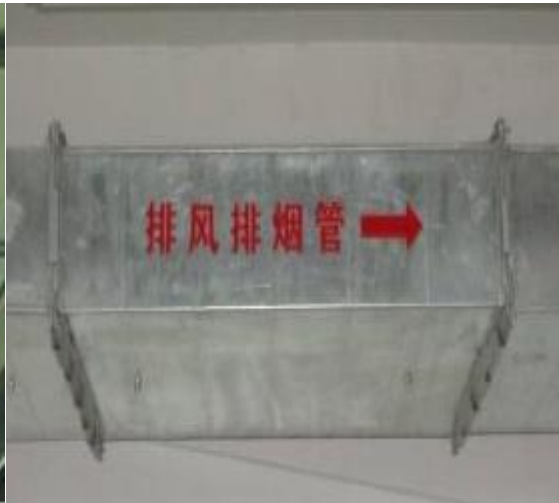
字体在风管侧面标识实例图
