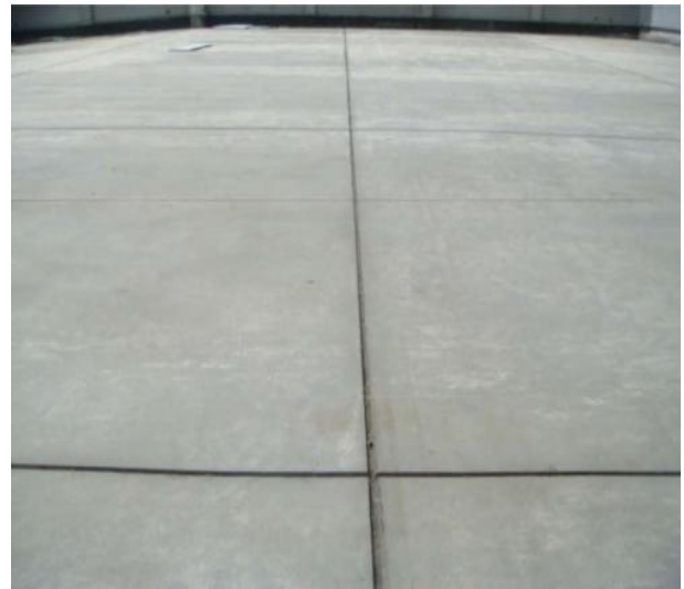
屋面混凝土面层效果图
